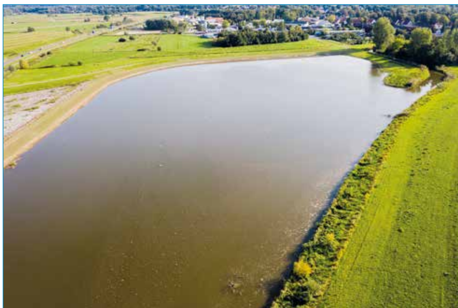
Rückhaltebecken mit Durchfluss der Aue. Eines der Gewässer des AV Horneburg
