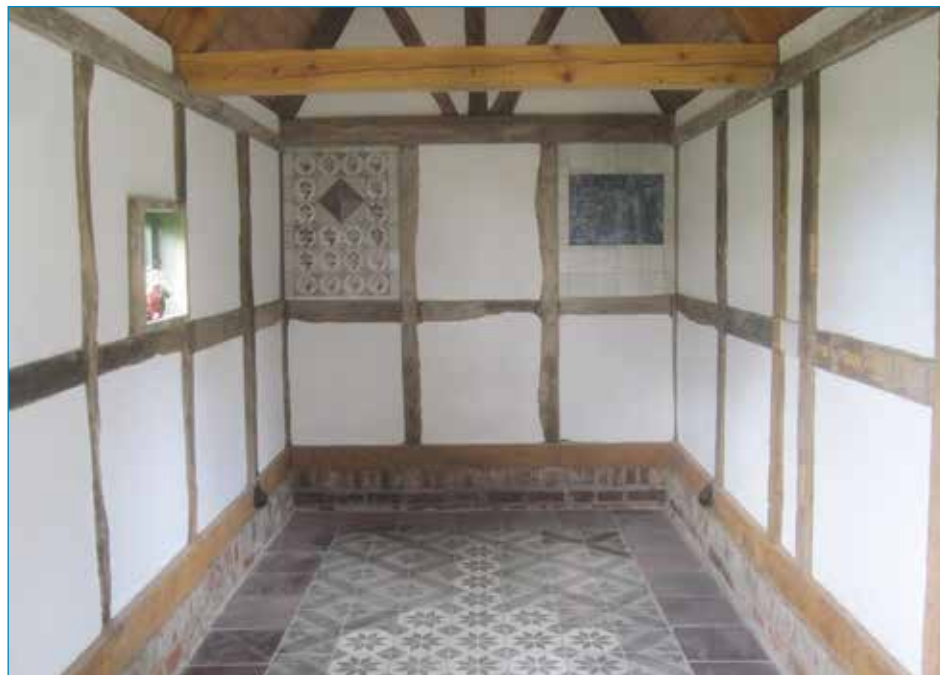
Innenansicht des Waschhauses.
