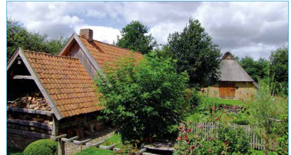
Backhaus und Schafstall um den Bauerngarten.
